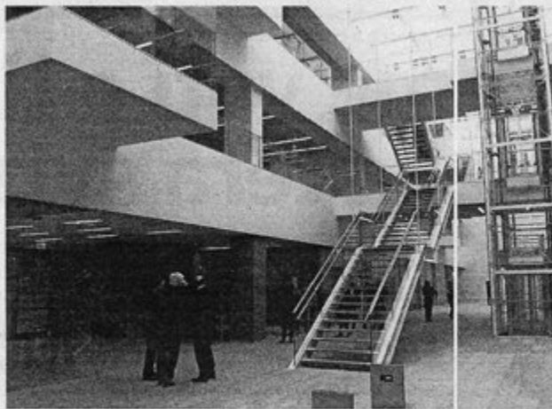
La grande hall centrale con spazi aggettanti.
